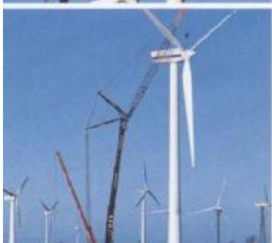
**Aufbau einer 1,5 MW Windenergieanlage im Windenergiepark Westküste**
